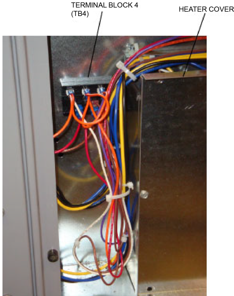
Fig. 51 — Heater Wiring
